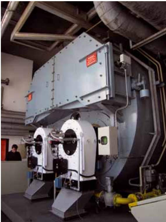
Bild 2: Kesselanlage während Umbau Fig. 2: Boiler system during modification
