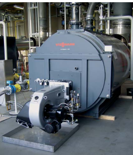
Bild 2: Viessmann Vitomax 100-LW M148 mit ELCO-Brenner
